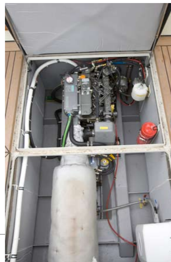
◀ Het gesloten koelsysteem aan boord van de MN 950 past goed bij een ondiep vaargebied. De bijbehorende droge uitlaat is voorzien van grote en geïsoleerde geluidsdempers.
