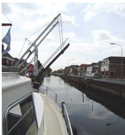
Eén van de vele bruggen over...
