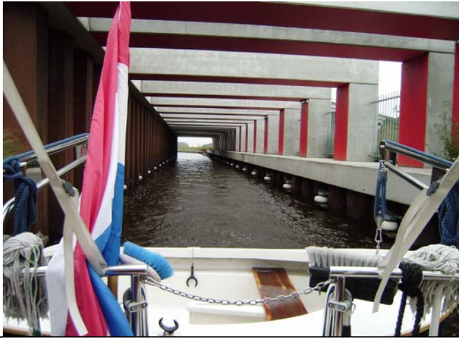
De toegangstunnel onder de rijksweg en de spoorlijn
