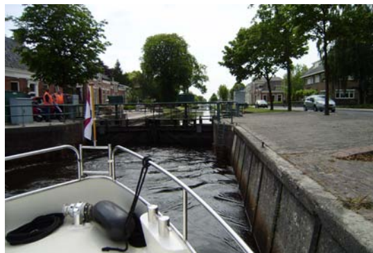
..en één van de twee sluisen in het Oosterdiep
